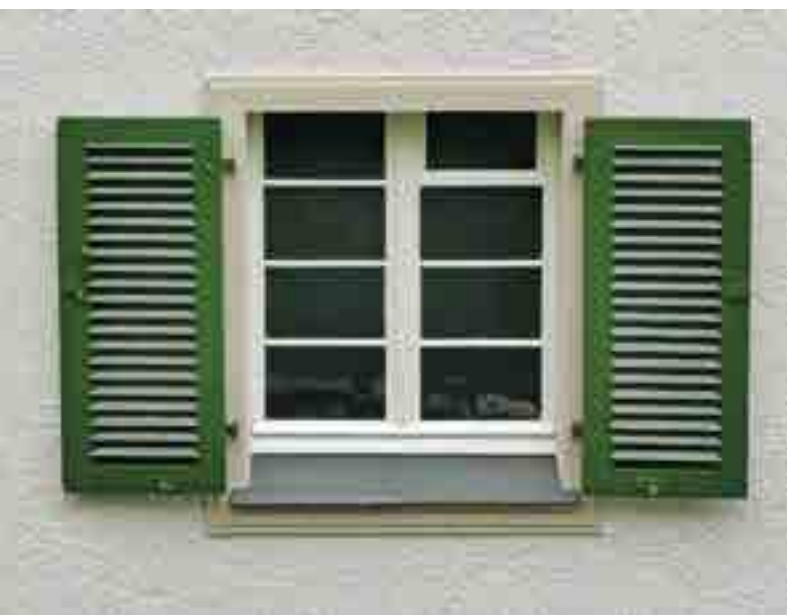
Bei Sanierungsarbeiten wurden jüngst originale Fenster und Fensterläden aus der Bauzeit der Siedlung entdeckt und denkmalgerecht erneuert
