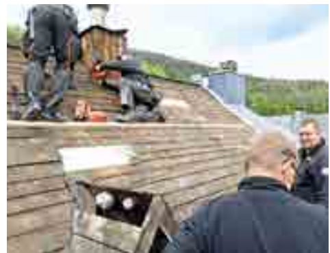
Beim jüngsten ABG-Denkmal in der Ackerstraße sind allein 1.700 m 2 Schieferdach neu einzudecken
